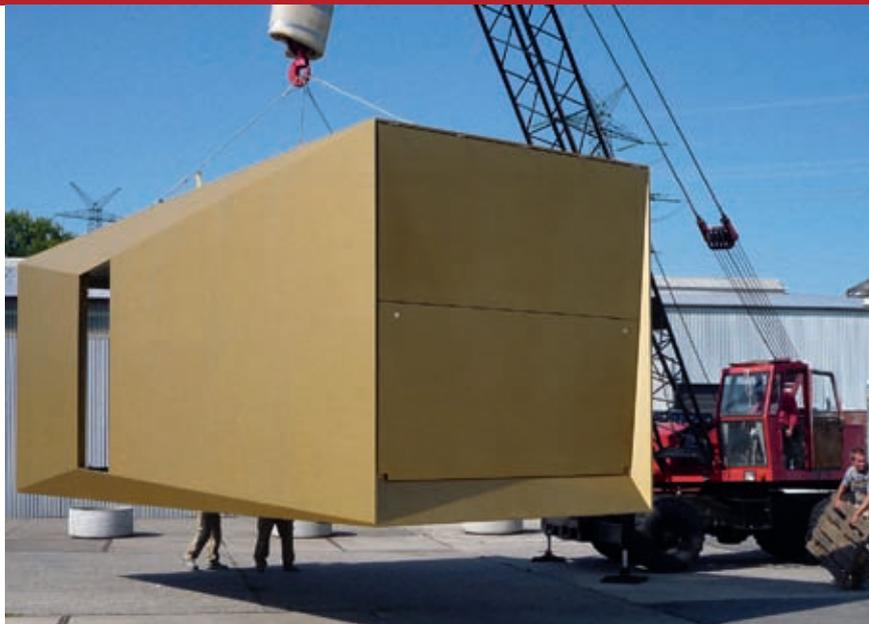
▲ Bild 1: Von Produktdesignern entworfene Raumzelle, die nach entsprechender technischer Ausstattung völlig energieautark bewohnt werden kann. Zur Ausrüstung gehören u.a. Solaranlage, Vakuum-Isolationspaneele sowie Regenwassersammel- und -aufbereitungsanlage.
