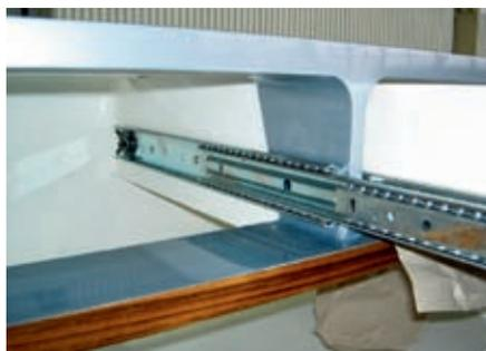
▲ Bild 9: Detailausführung Schubkastenführung
