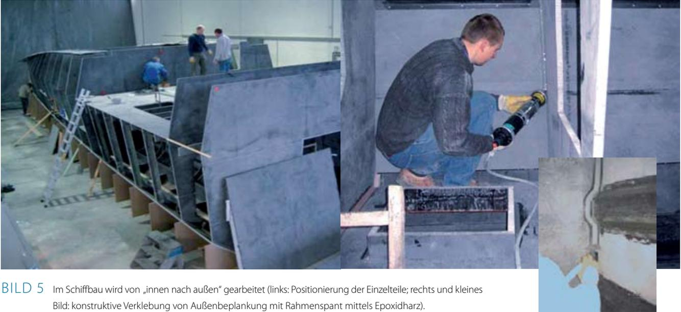
**BILD 5** Im Schiffbau wird von „innen nach außen“ gearbeitet (links: Positionierung der Einzelteile; rechts und kleines Bild: konstruktive Verklebung von Außenbeplankung mit Rahmenspant mittels Epoxidharz).
